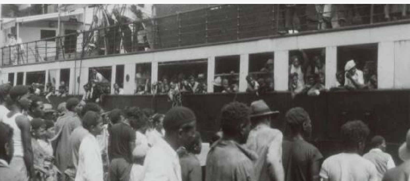
Nouméa. Départ d'un convoi de coolies javanais, entre 1929 et 1935, FR ANOM 31Fi49/129.
